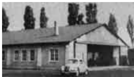
Die neu erbaute Flugzeughalle
