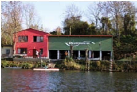
Bootshaus nach der Rekonstruktion 2005
